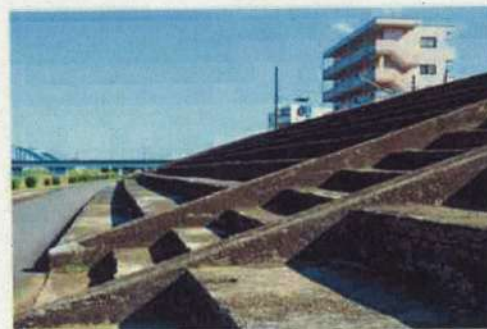
国土交通省京浜河川事務所が実施した観客席のレーダー探査によると、コンクリートの厚さは観客席部分で約160mm、階段部分で約170mmあり、ともに無筋(鉄筋がない)であった。そのコンクリートの下には細粒分のない100mm以上の大きさの玉石が敷かれているという。5年前の80周年に多摩川スピードウェイの会から寄贈された記念プレートについては切り出される予定で、工事に合わせて切り出される観客席の一部とともに移設を目指している。
