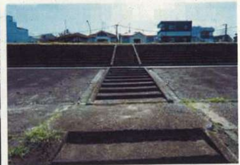
国土交通省京浜河川事務所が実施した観客席のレーダー探査によると、コンクリートの厚さは観客席部分で約160mm、階段部分で約170mmあり、ともに無筋(鉄筋がない)であった。そのコンクリートの下には細粒分のない100mm以上の大きさの玉石が敷かれているという。5年前の80周年に多摩川スピードウェイの会から寄贈された記念プレートについては切り出される予定で、工事に合わせて切り出される観客席の一部とともに移設を目指している。
