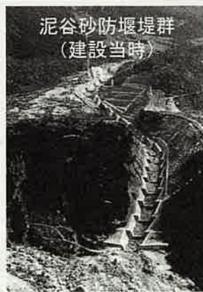
計20基の砂防堰堤が階段状に配置
