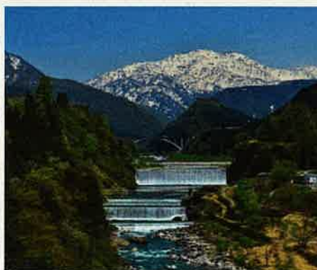
本宮砂防堰堤
