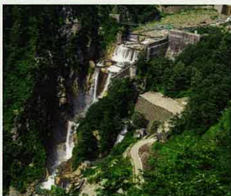
白岩砂防堰堤
